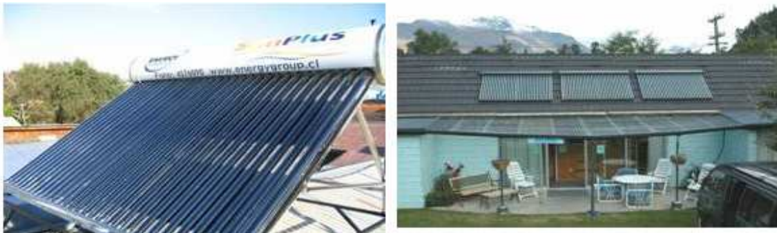
Equipo termosifón e instalación solar con circulación forzada - colectores tubulares (materiales importados Sunplus) (Fuente: www.energygroup.cl )
