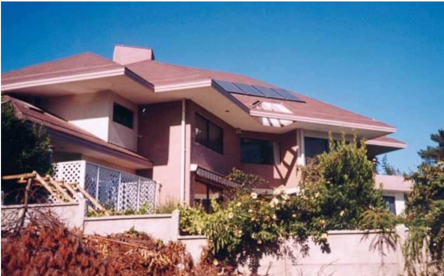
Instalación con colectores planos para el calentamiento de agua de una vivienda (Fuente: www.ingesolltda.cl )
