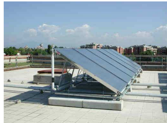
Instalación con colectores planos para el calentamiento de agua de una vivienda (Fuente: www.ingesolltda.cl )
